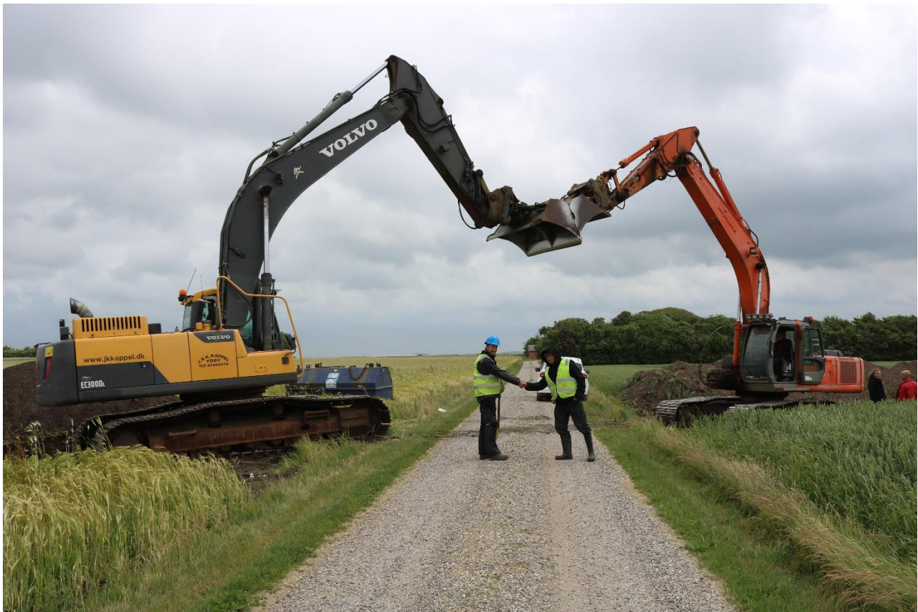
Figur 19. Muldafrømningen af det lange tracé var et stort arbejde, og krævede i perioder brug af to gravemaskiner, der gravede fra hver sin ende. Her mødes de på en mark bag Skinnerup og markerede dermed afslutningen på muldafrømningen.
